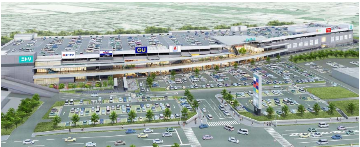
◆国道1号線方向(西側)からの施設全景
