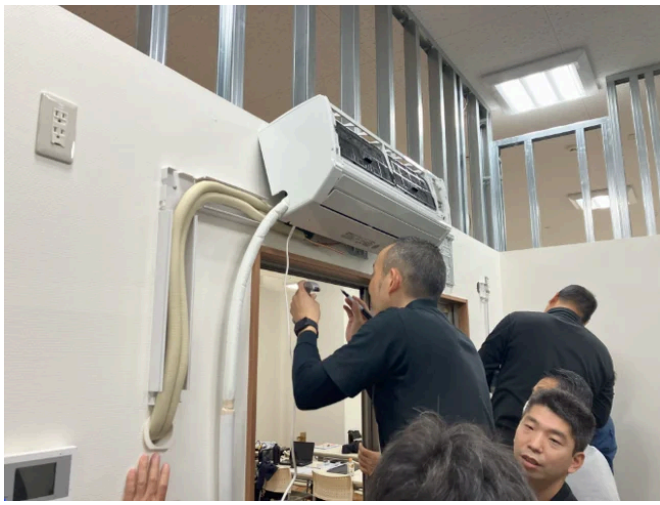
エアコン室内機設置を学ぶようす
