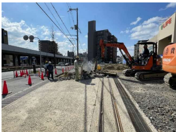
粉じん飛散防止対策 (散水状況)
