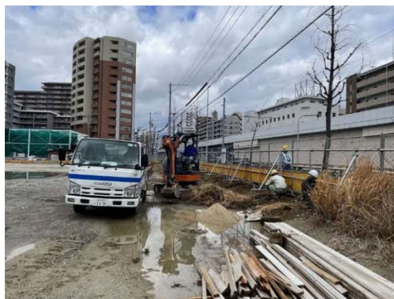
場内清掃状況
